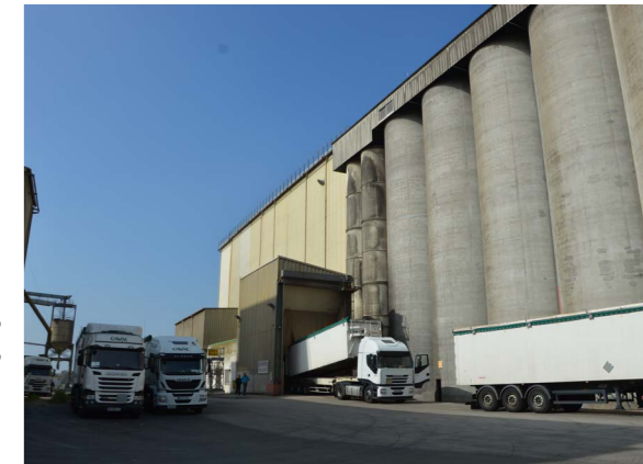
L'usine de Fougeré
