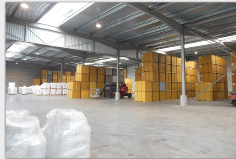
Un nouveau bâtiment de stockage a été construit à la station semences de Mouilleron-Le-Captif.
