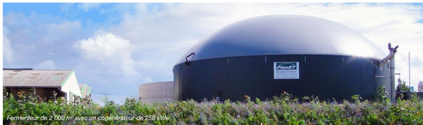
Fermenteur de 2 000 m<sup>3</sup> avec un cogénérateur de 250 kW<sub>e</sub>
