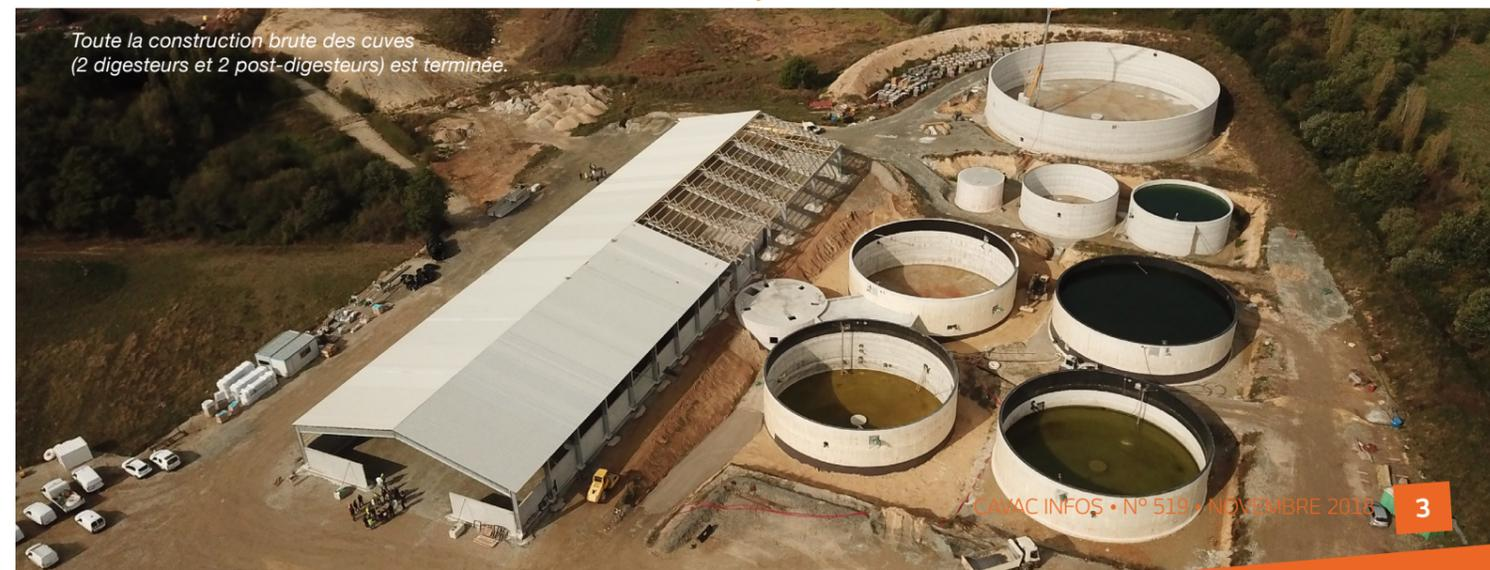
Toute la construction brute des cuves (2 digesteurs et 2 post-digesteurs) est terminée.
