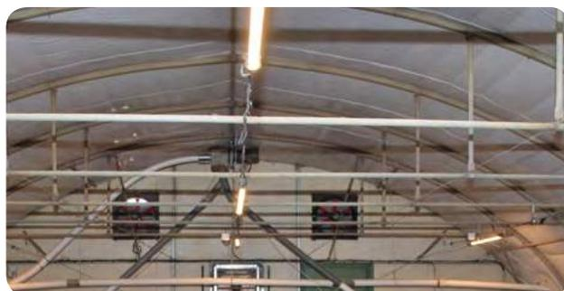
L'éclairage avec des tubes à LED reproduit une journée normale : ces tubes sont programmés pour s'allumer et s'éteindre progressivement. Les tubes à LED ont été choisis pour éviter les rayonnements électromagnétiques émis par les tubes à néon.
