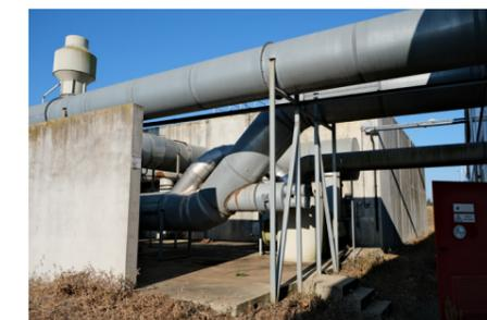
L'air extrait est intégralement désodorisé dans un biofiltre de 350 m<sup>2</sup> composé d'écorce de bois, ainsi que dans une tour de lavage équipée d'un filtre à charbon.
