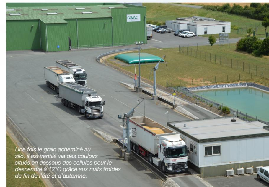
Une fois le grain acheminé au silo, il est ventilé via des couloirs situés en dessous des cellules pour le descendre à 12°C grâce aux nuits froides de fin de l'été et d'automne.
